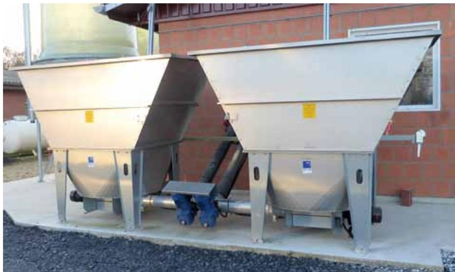
2 Stück UNI-Dos Typ 45 in Edelstahlausführung mit 3,2 m<sup>3</sup> Lagervolumen, Entnahmeschnecke Typ 160, Abdeckung aus Edelstahl mit Handkurbel
