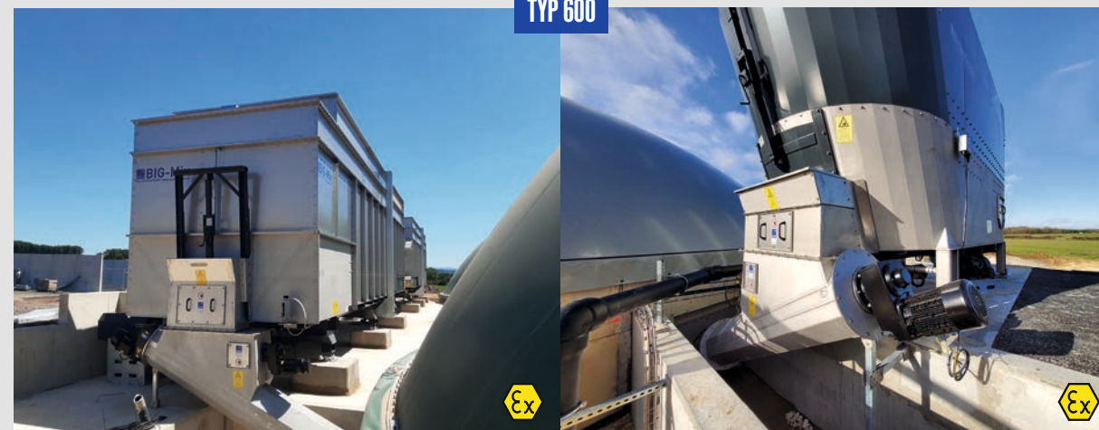
Fermenterschnecken TYP 600 nach ATEX beschicken direkt den Fermenter. Beide Anlagen sind dafür mit einer Schieberöffnung ausgestattet.
