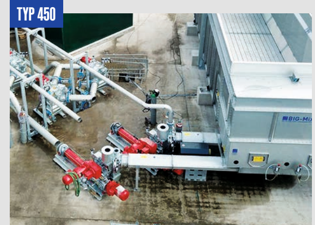
Ein Zuführsystem mit zwei angeschlossenen Förder-schnecken des TYPs 450 beschickt zugleich zwei externe Flüssigeintragsysteme.
