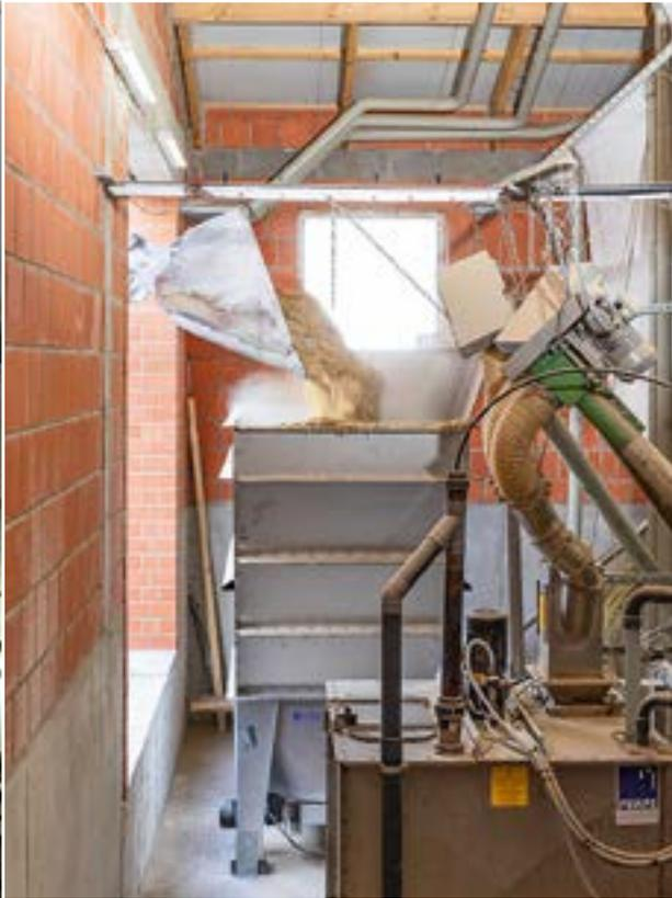
*Herzstück der Anlage ist der Uni-Dos-Vorratsbehälter. Befüllt wird in diesem Fall mit dem Frontlader.*
