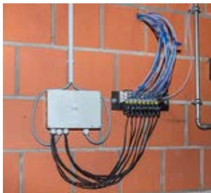
Zentrale Elemente wie die Pneumatikverteilung werden im trockenen Zentralgang installiert.
