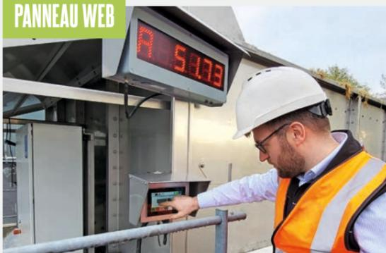
Un panneau web de haute qualité est l'élément de commande de la technique de contrôle. Installé dans un boîtier en acier inoxydable avec un capot de protection contre les intempéries, l'écran peut être placé à n'importe quel endroit convivial de votre installation et, si nécessaire, être intégré à d'autres interfaces.
