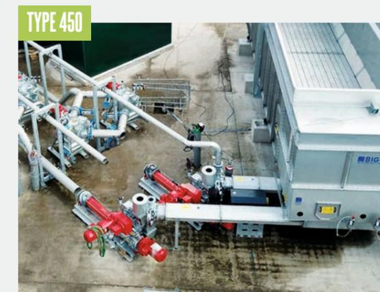
Un système d'alimentation avec deux vis sans fin TYPE 450 raccordées alimente simultanément deux systèmes d'alimentation en liquide externes.
