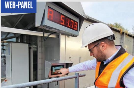
Ein hochwertiges Web-Panel ist das Bedienelement der Steuerungstechnik. Das im Edelstahlgehäuse mit Wetterschutzhaube verbaute Display kann an jeder bedienungsfreundlichen Stelle Ihrer Anlage angebracht und bei Bedarf an weitere Schnittstellen eingebunden werden.
