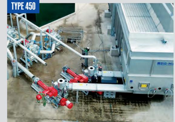
Un système d'alimentation avec deux vis sans fin TYPE 450 raccordées alimente simultanément deux systèmes d'alimentation en liquide externes.
