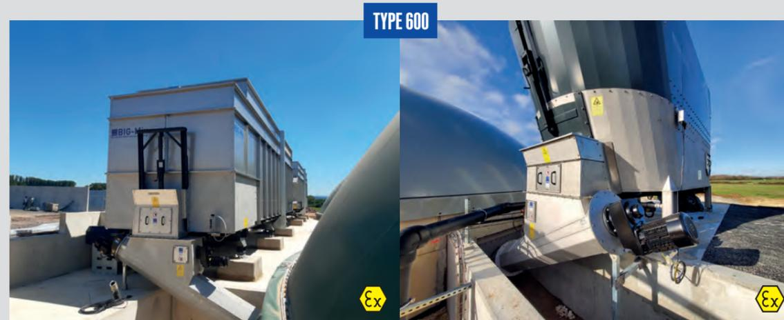
Les vis de fermenteur TYPE 600 selon ATEX alimentent directement le fermenteur. Les deux installations sont équipées à cet effet d'une porte coulissante.
